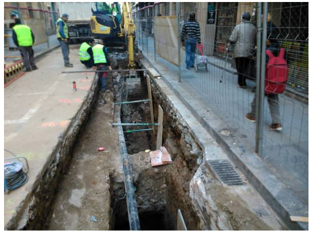
50. Excavació a la part central del Tram 3
