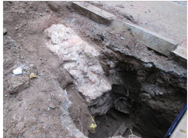
16. Mur de façana UE 9 a l'extrem NO del Tram 2
