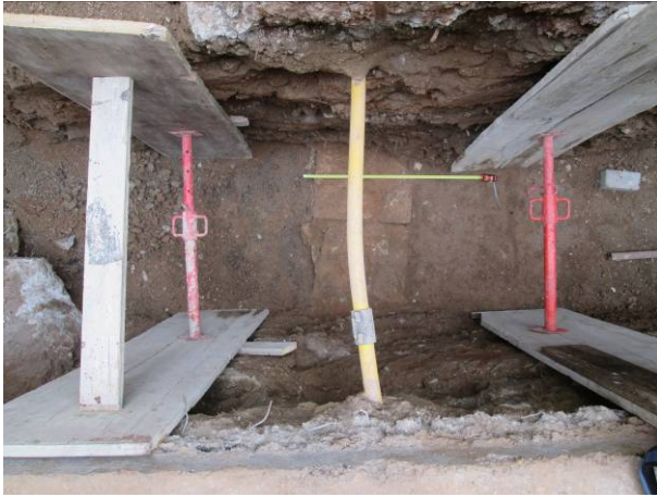
25. Mur UE 6 i rasa de construcció UE 7
