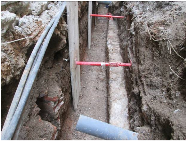
7. Detall de la canalització UE 13 front la finca núm. 5
