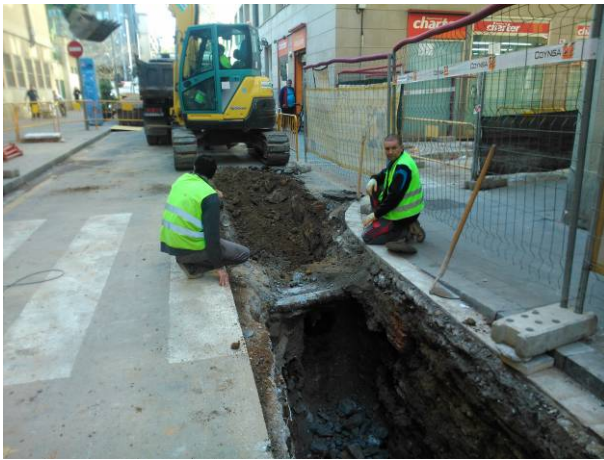
49. Excavació a l'extrem SO del Tram 3
