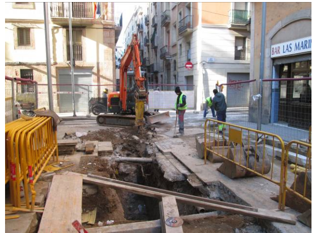
14. Excavació a l'extrem NO del Tram 2
