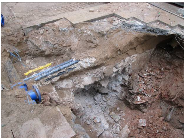
35. Desmuntatge del mur UE 9
