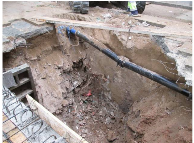
34. Mur UE 9 i sediment UE 22
