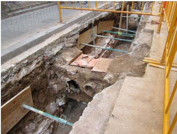
51. Vista general de la canalització UE 26
