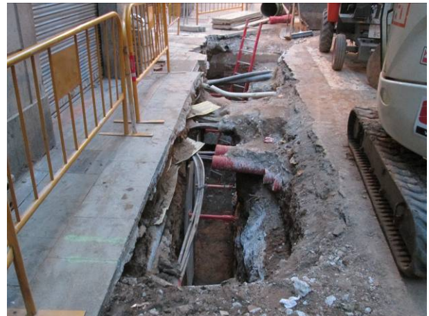
10. Serveis a l'extrem SE del Tram 1
