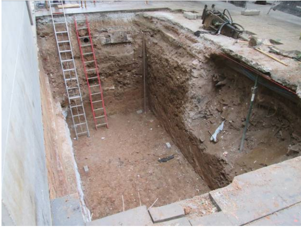
31. Vista general de l'arqueta
