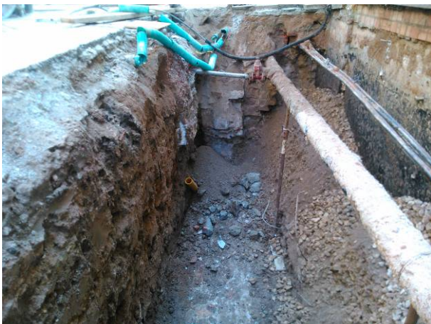
47. Cantonada del mur UE 9 a l'alçada del carrer Nou de la Rambla
