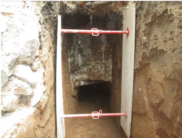
21. Col·lector del carrer del Marquès de Barberà
