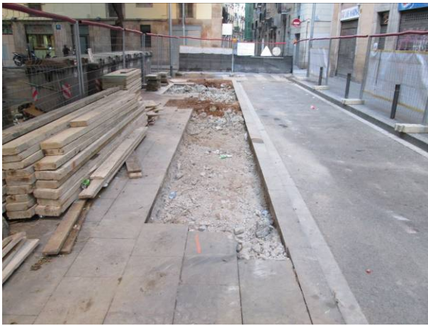
13. Retirada del paviment a l'extrem NO del Tram 2
