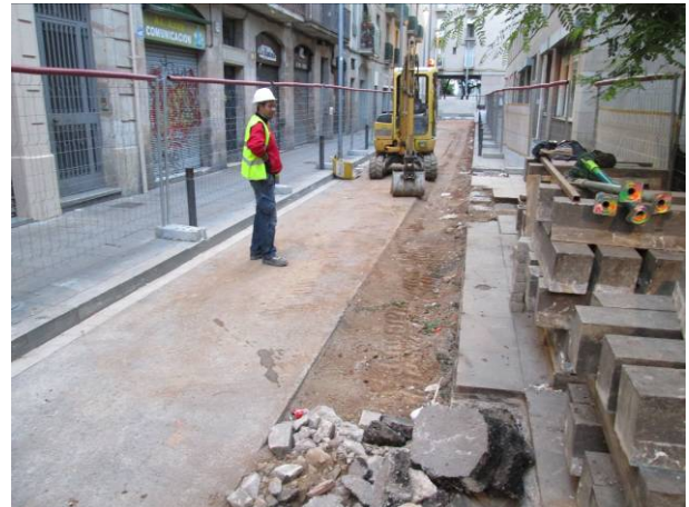
22. Retirada de l'asfalt a la part central del Tram 2
