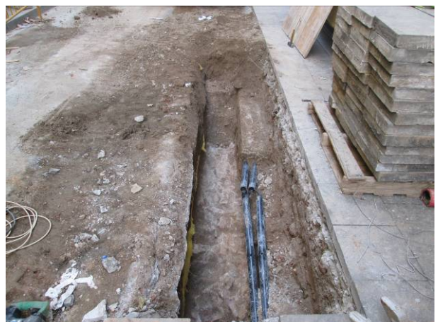
36. Mur UE 9 cobert per serveis actuals front la finca núm. 27
