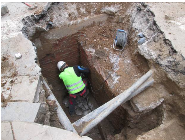
11. Cruïlla de col·lectors entre el carrer de Sant Ramon i Marquès de Barberà
