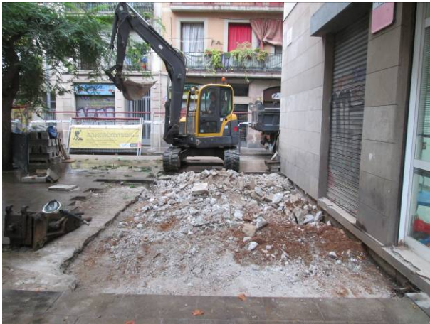
27. Retirada del paviment a l'arqueta de la plaça Pieyre de Mandiargues
