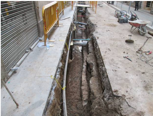
5. Canalització UE 13 a la dreta de la rasa
