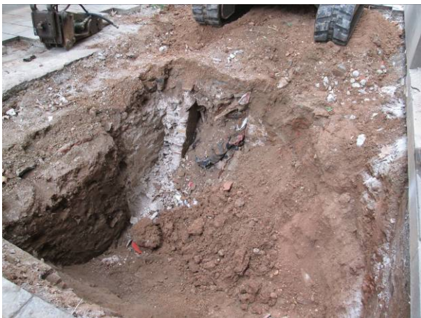
29. Escala d'accés al soterrani UE 19
