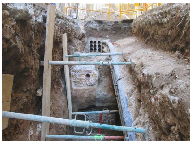
54. Canalització UE 26 a l'extrem NE del Tram 3
